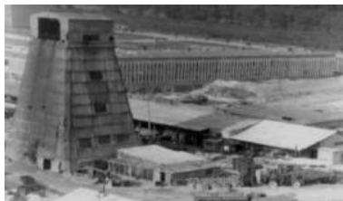
Oficjalne rozpoczęcie budowy huty w Głogowie
